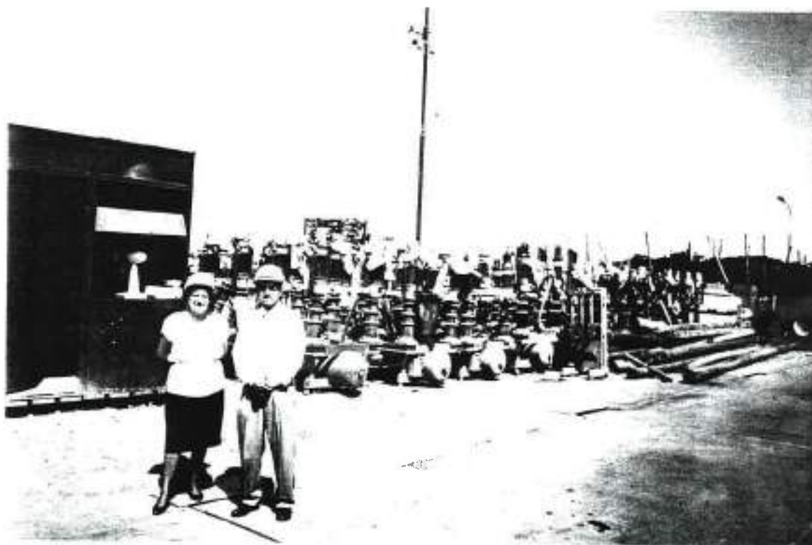
AREA DE RECICLAJE ORDENADA PARA UN MEJOR CONTROL
