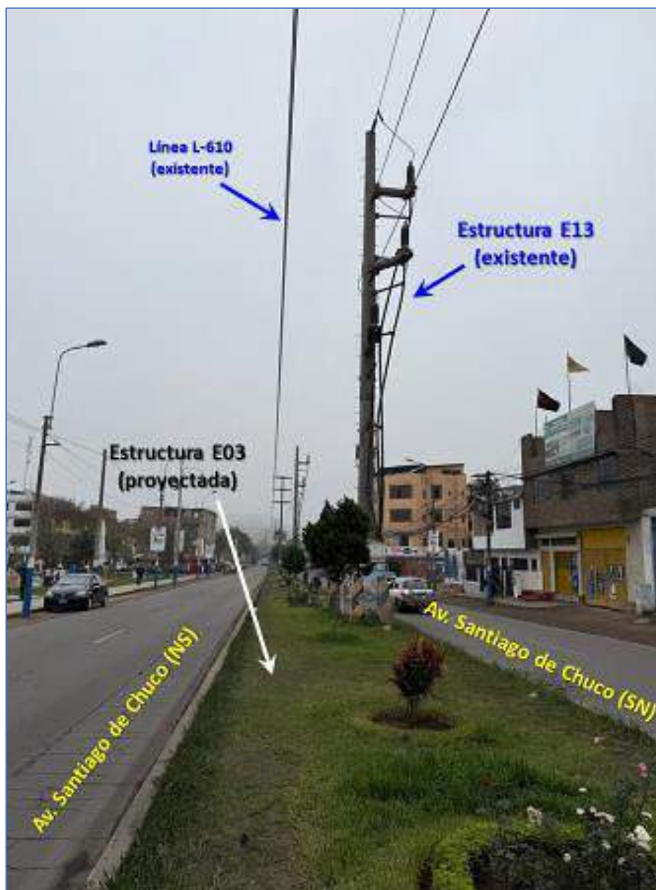
Figura 3.8. Detalle ubicación para poste E03 en Zona 2
