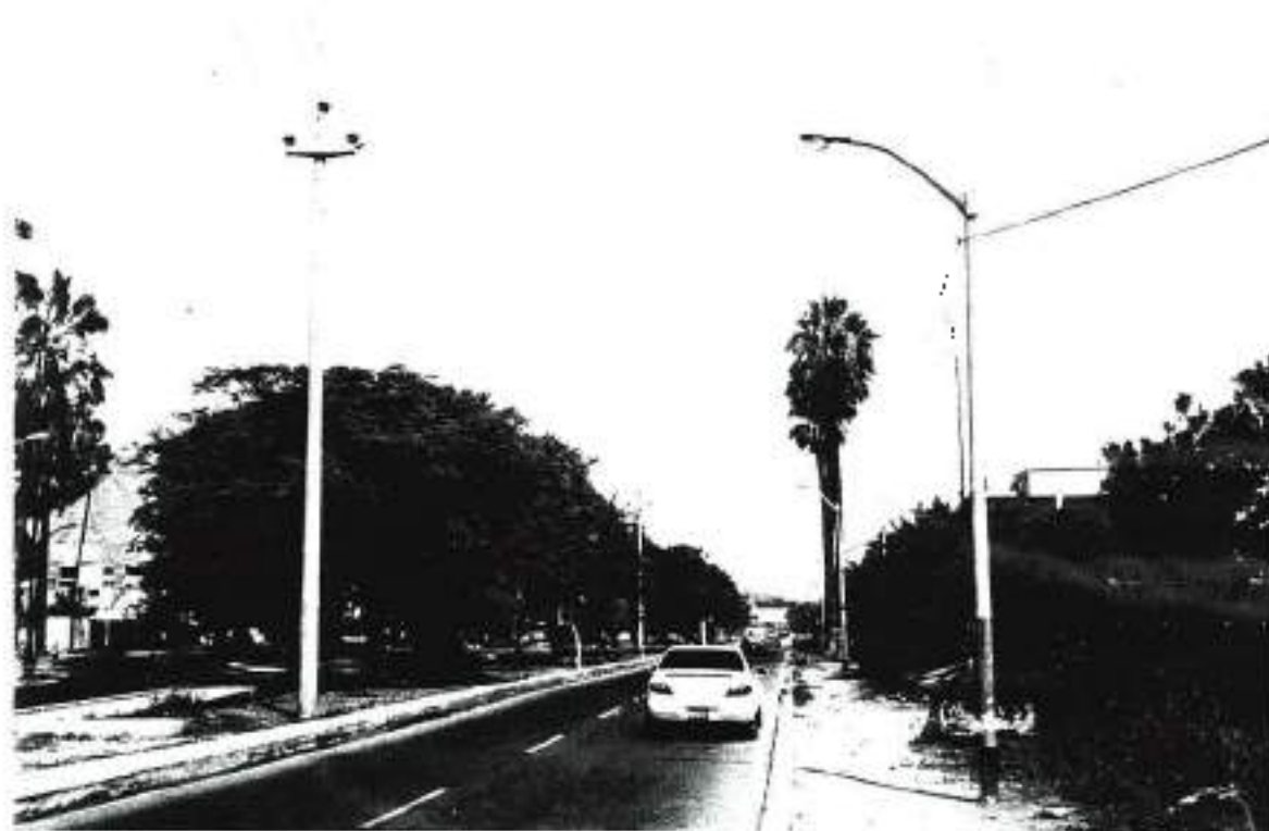
REEMPLAZO DE POSTES AV. VELASCO ASTETE
