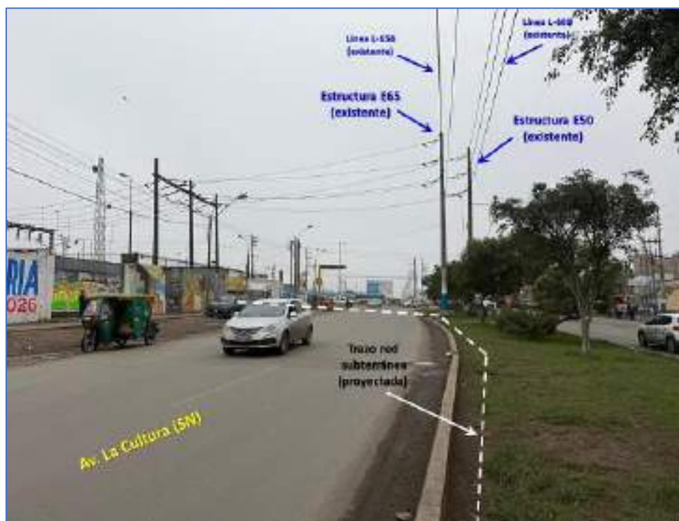
Figura 3.7. Detalle trazo para red subterránea e ingreso a SET Santa Anita en Zona 1
