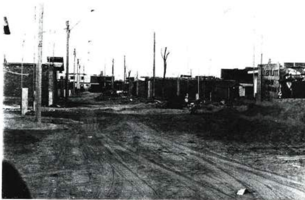
ELECTRIFICACIÓN EN EL ÁREA DEL CENTRO DE SERVICIO SAN JUAN (#1)
