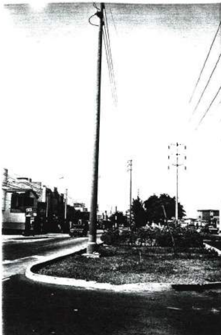
REEMPLAZO DE POSTES AV. INTIBUATANA
