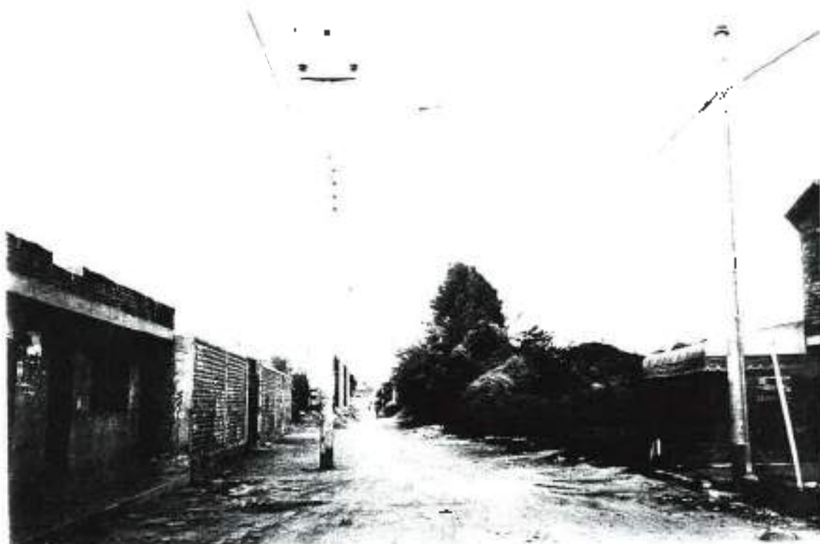
ELECTRIFICACIÓN EN EL ÁREA DEL CENTRO DE SERVICIO SAN JUAN (#2)
